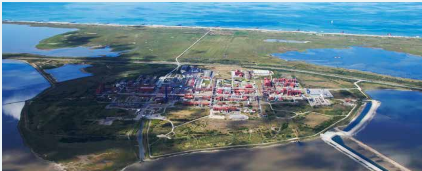
Luftfoto over Rønland fra 2019. Foto: Region Midtjylland
